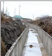
ше, и канал, будучи в заброшенном со-стоянии, сильно портил картину: больно было смотреть на это зрелище до начала реконструкции. Работники ООО «Капремстрой» соорудили на этом участке современный мост в районе магазина «Магмус», облегчив движение транспорта. Канал теперь бетонирован с двух сторон, днище бетонировано. Теперь и чистить удобно, и ил, как на грунтовом дне, не останется.
